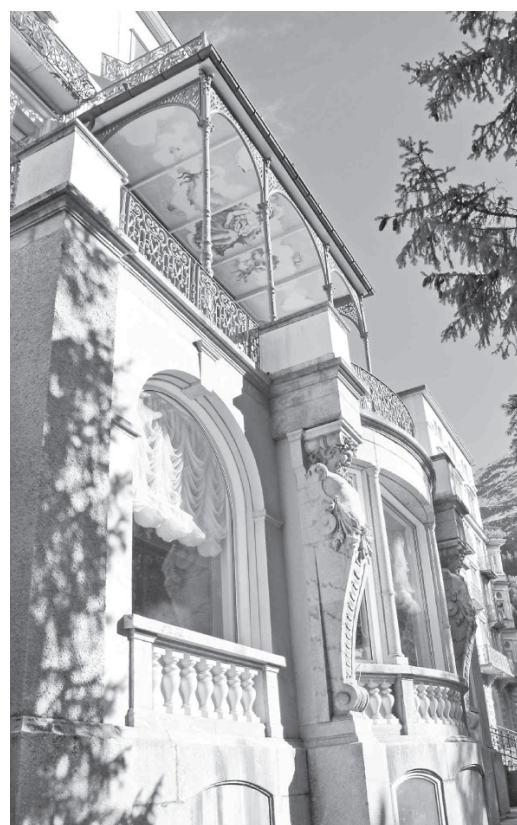
Aussenansicht (Südwest-Fassade). Äusserlich wurde das Hotel nicht erneuert.
